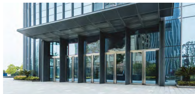
Deur- en gevelbouw
